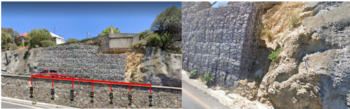
FIGURA 1. Imagen del arreglo del muro de gaviones.
