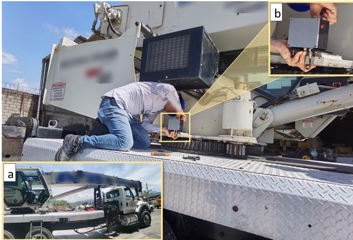
FIGURA 11. Instalación del inclinómetro en la tornamesa de en una grúa con capacidad de 45 toneladas, a) fotografía de la grúa, b) detalle del sensor.
