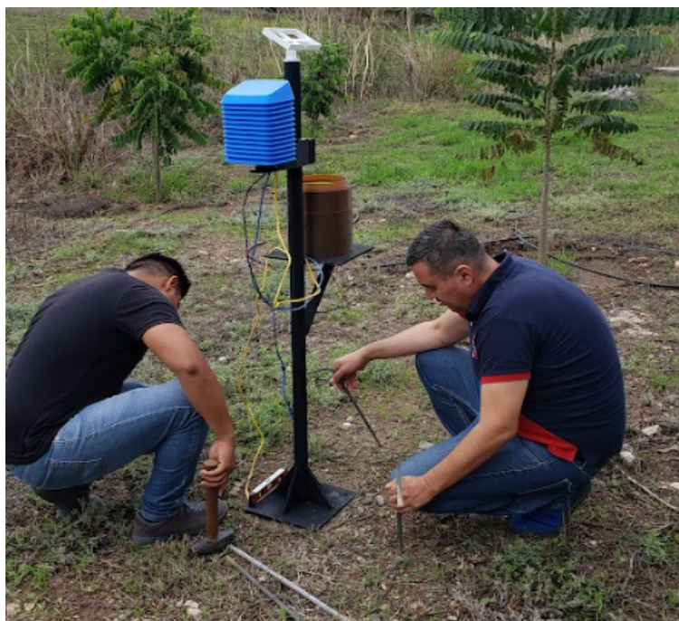
Figura 11: Instalación de la estación de monitoreo. Imagen propia.
