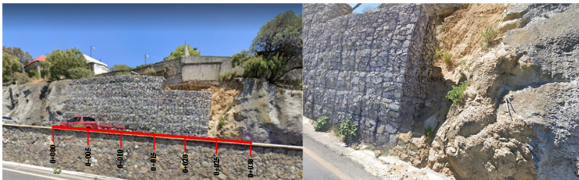
FIGURA 1. Imagen del arreglo del muro de gaviones.
